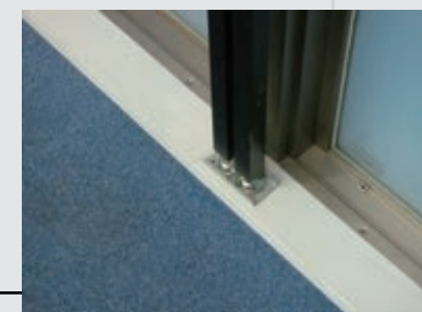
アジャスターを突っ張る面にコの字金具を 両面テープで貼付け、1台あたり上下2ヶ所 ずつ突っ張り、固定をします
